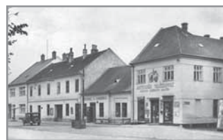
Obr. 12. Benzinová stanice před domem č. p. 149, stav ve čtyřicátých letech 20. století.
