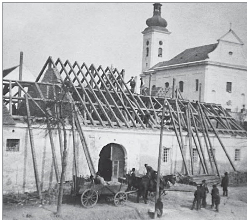
Obr. 23. Bourání části Penkova dvora předcházel stavbě nové školy.
