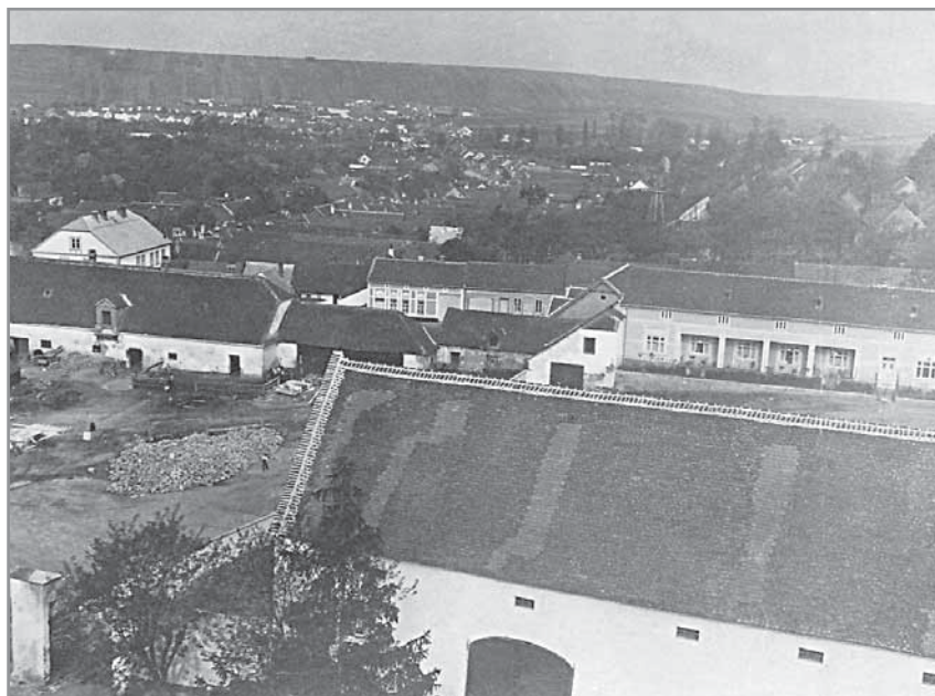
Obr. 6. Pohled z kostelní věže do Penkova dvora, stav před rokem 1929.
