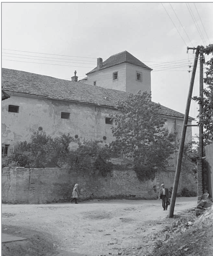
Obr. 32. Sloupy starého elektrického vedení za tvrzí.
