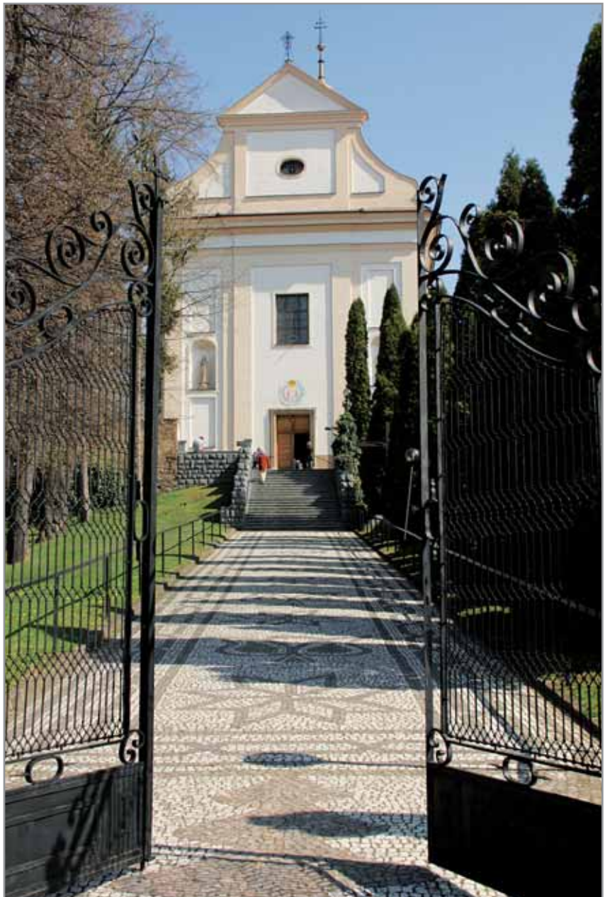
Obr. 3. Přístupová cesta ke kostelu sv. Vavřince. Foto Petr Titz.
